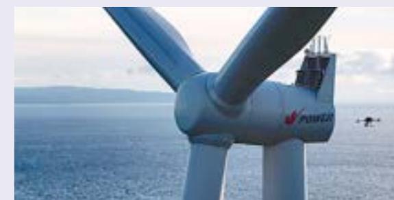
自律飛行するドローンが、洋上風力設備の点検を効率的に実施
