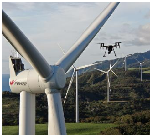
<本点検の様子>
